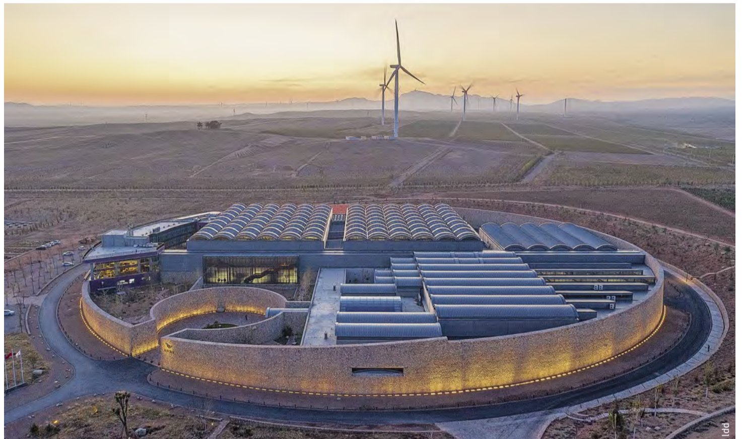
Le chai de Xige Estate, dans le Ningxia, comprend sur 25 000 mètres carrés des ateliers de production et un centre de dégustation.
